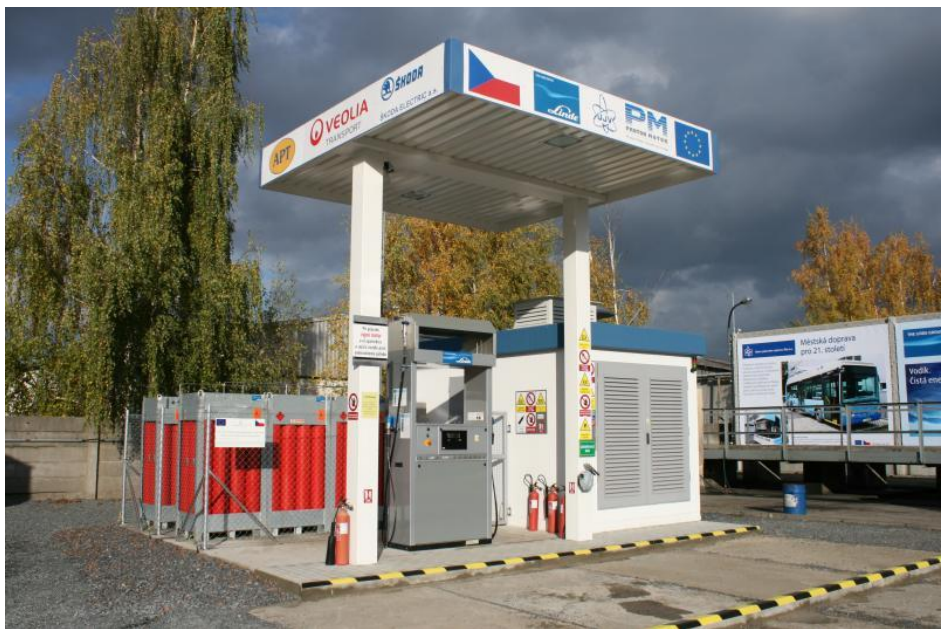
Obr. 17: Čerpací stanice vodíku
